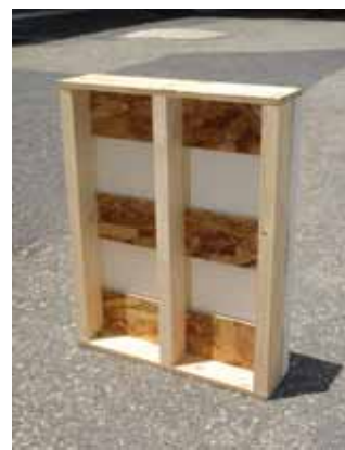
(内部、枠、間柱、断熱受け合板、断熱材)
