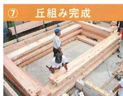
⑦ 丘組み完成 フレーム本数分を組立て(上棟前日までに全フレームを丘組み)
