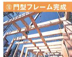
⑩ 門型フレーム完成 フレームと軸組の接続完了
