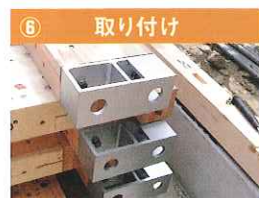
⑥ 取り付け フレーム本数分の柱脚金物を取り付け
