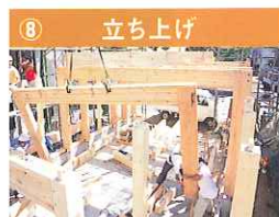
⑧ 立ち上げ クレーンによるフレームの取付け
