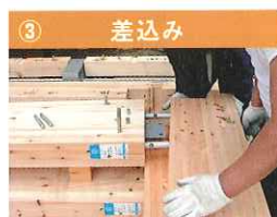
③ 差込み 梁と柱をセット(仮止めした接合金物に柱を差込む)
