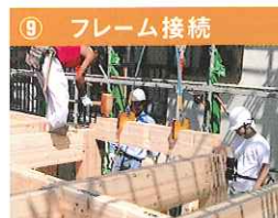
⑨ フレーム接続 フレーム間を接続(フレーム以外の柱・横架材をセット)
