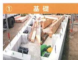
① 基礎 基礎にアンカーボルトを埋込む
