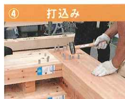
④ 打込み 梁と柱にドリフトピンを打込み固定
