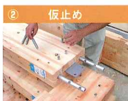
② 仮止め 梁に接合金物をドリフトピンで仮止め
