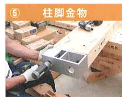
⑤ 柱脚金物 柱脚に専用金物を取付け
