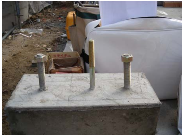
ラーメンフレーム用アンカーボルト(右側)
