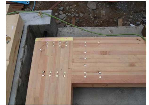
ラーメンフレーム接合後
