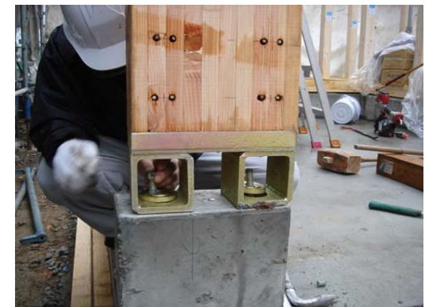
ラーメンフレーム柱脚金物固定
