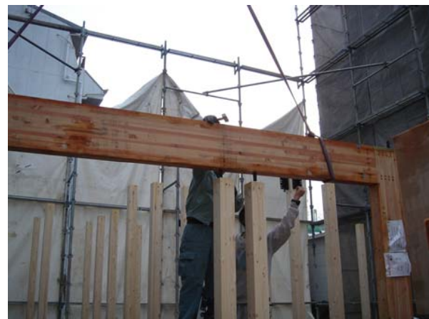
ラーメンフレーム建方
