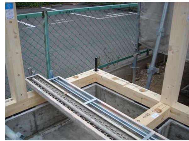
HSB柱脚金物土台納まり
