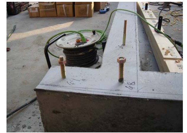
ラーメンフレーム用アンカーボルト(左側)
