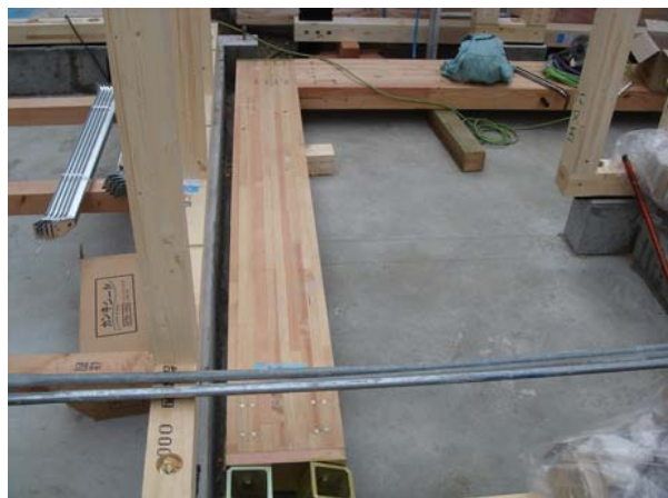
ラーメンフレーム接合後
