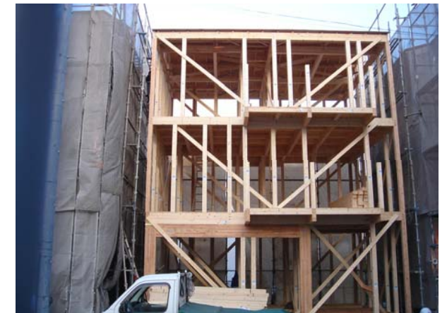
ラーメンフレーム施工全景
